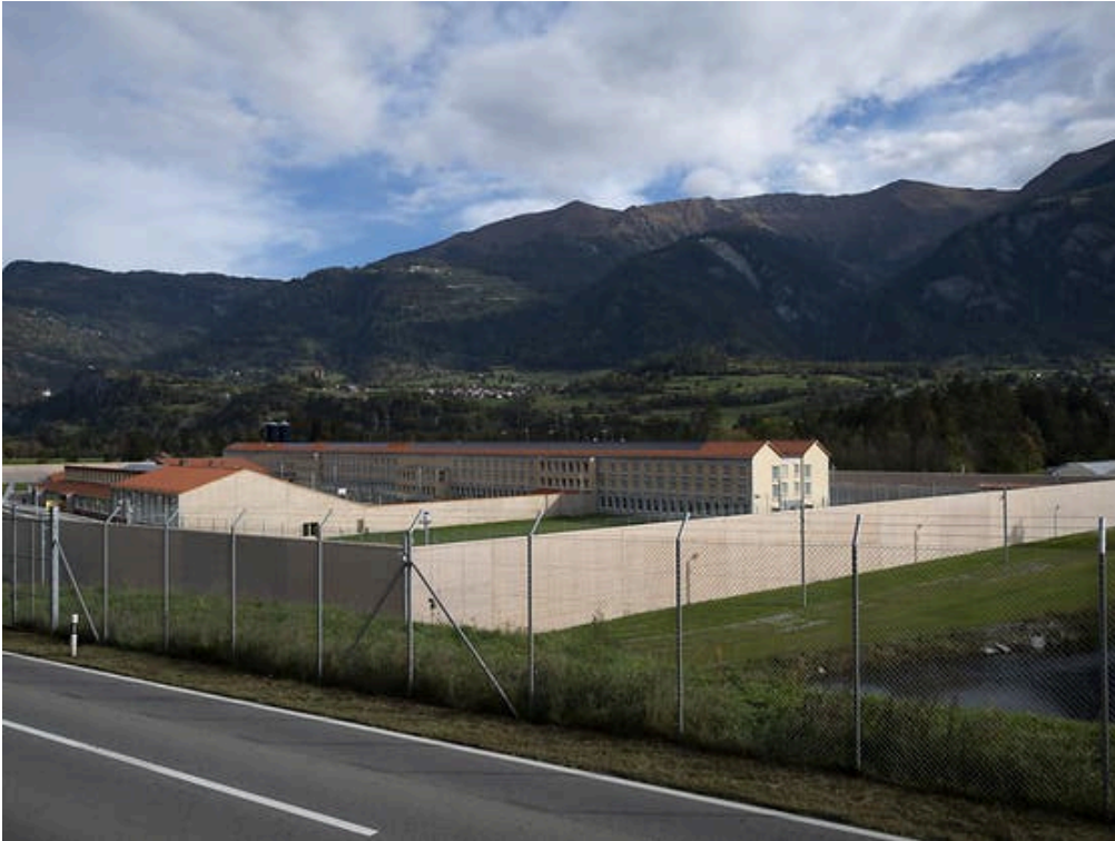
Blick auf die neu gebaute Justizvollzugsanstalt Tignez in Cazis GR: Das Gefängnis soll nach einer Testphase im Januar bis zu 152 Inhaftierte aufnehmen. (Bild: KEYSTONE/GIAN EHRENZELLER)
